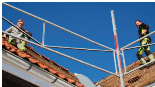
Glenn Tesaker og Rolf Birkeland fra Stangborli Bygg AS
